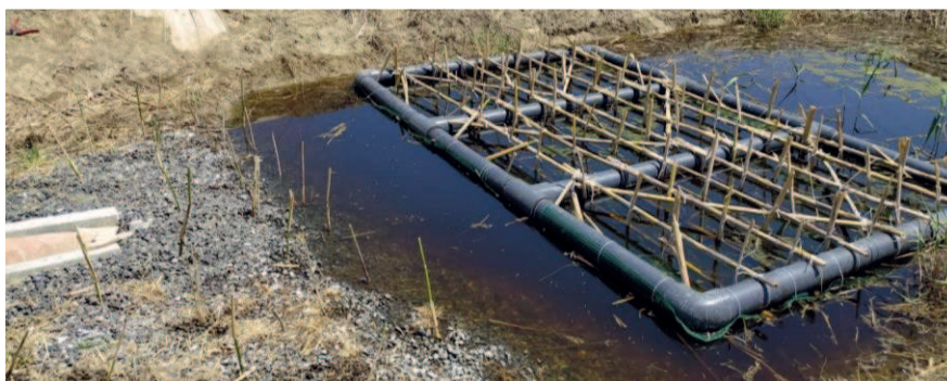
Figura 18: Vista, a luglio 2020, della vasca FWS in seguito al completamento delle operazioni di manutenzione.
